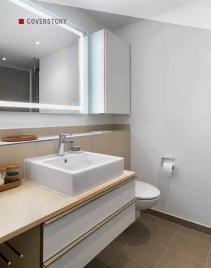
Die vollkommen vorgefertigten Badmodule von Züblin Timber wurden vor Ort lediglich angeschlossen.
