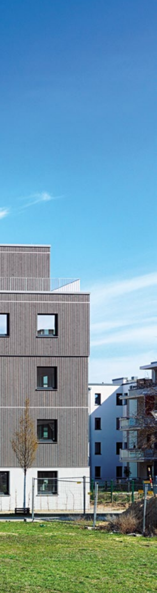
Das Projekt „Urbaner Holzbau“ in Berlin
