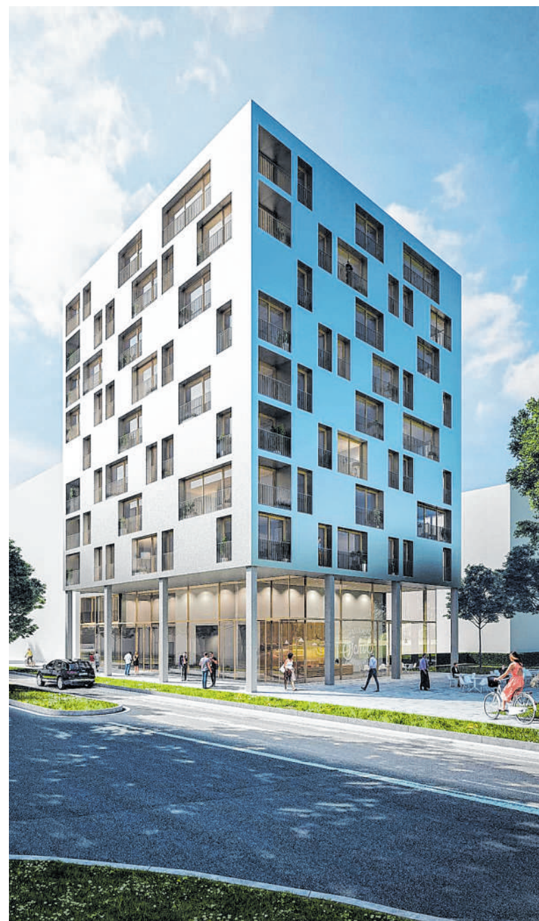
Ganz ohne Beton kommt die Konstruktion nicht aus und die äußere Haut besteht aus Aluminium, doch Wände und Decken sind aus Holz: „Skaio“ in Heilbronn, ein Projekt des Berliner Architekturbüro Kaden+Lager. BILD: KADEN+LAGER/VISUALISIERUNG THIRD
