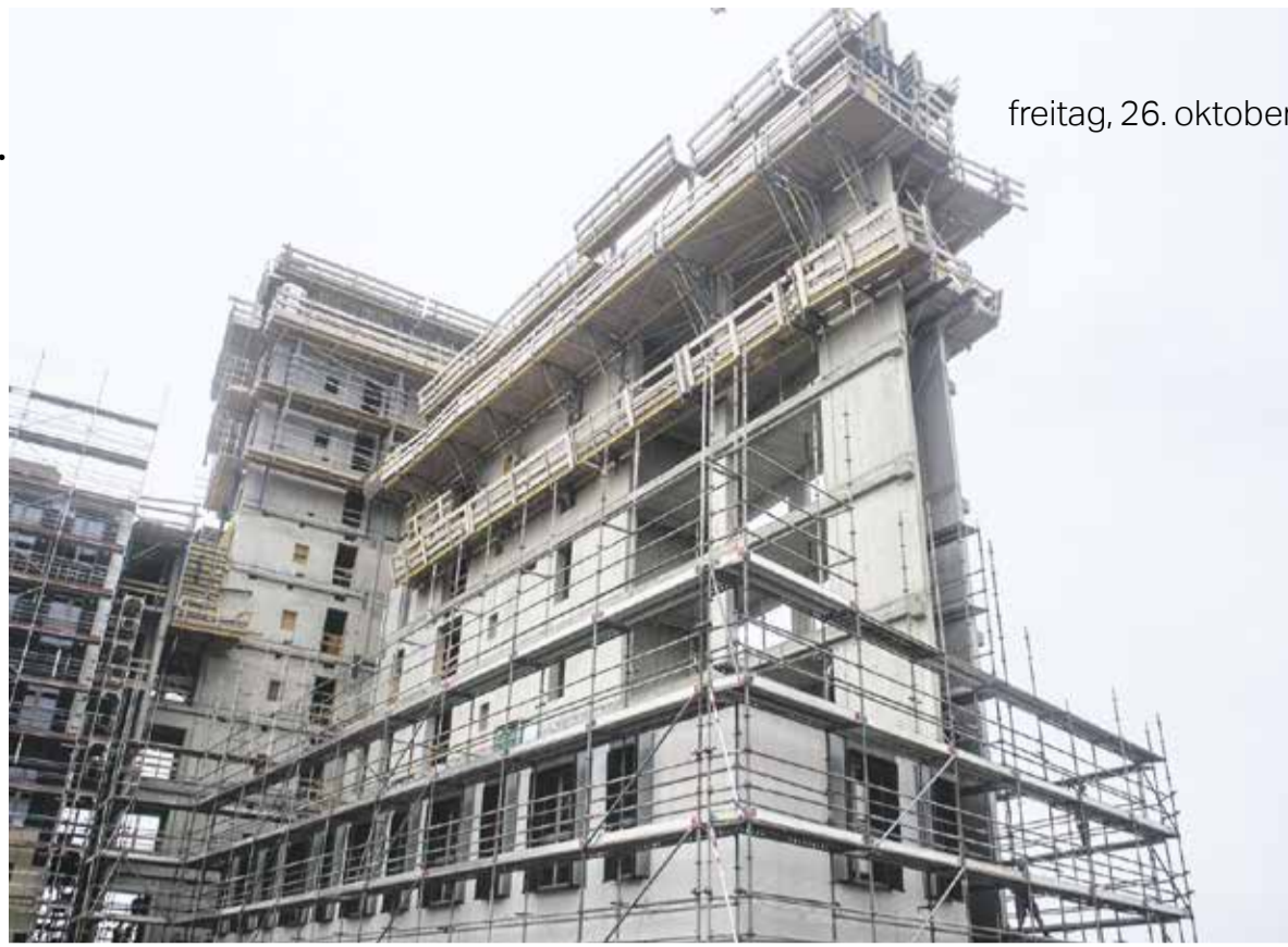
Wächst noch: Der Kern des Wiener Hochhauses besteht aus Beton. Alles andere wird aus Holz gebaut Foto: Sabine Seifert
