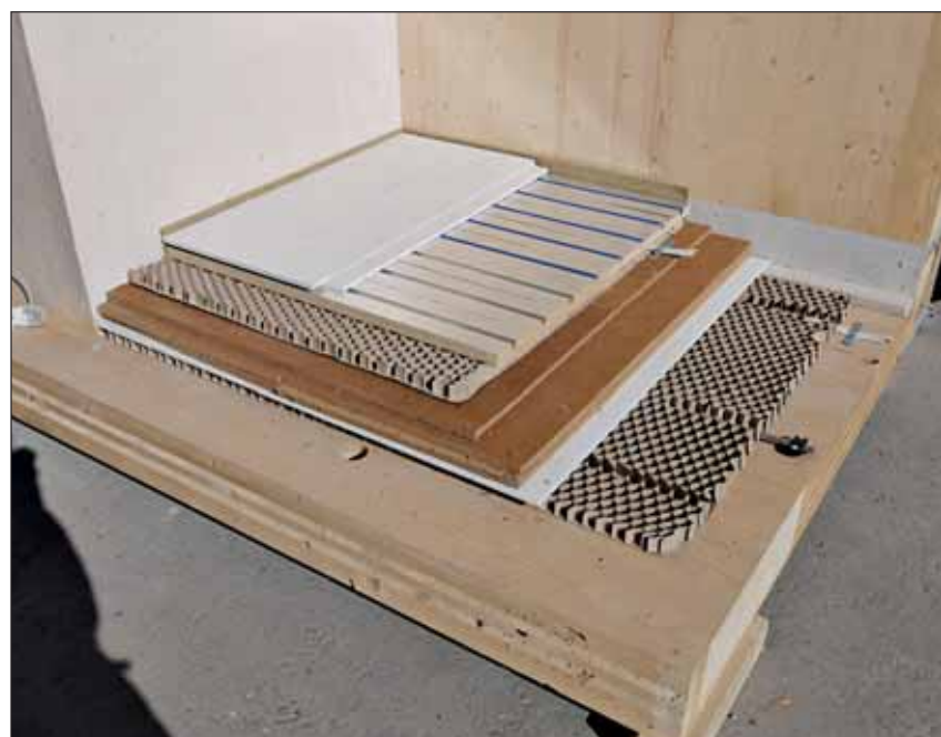
Hoher Aufwand für effektive, aber wieder zerlegbare Trittschalldämmung
