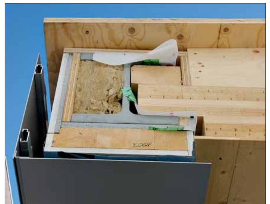
Fassadenseitiges Auflager der Massivholzdecke auf den umlaufenden Stahlträger
