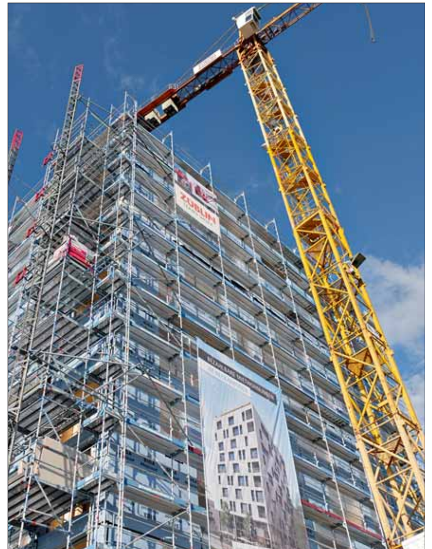
Was für Wien das „Ho-Ho“ ist, ist für Heilbronn der Leuchtturm „Skaio“
