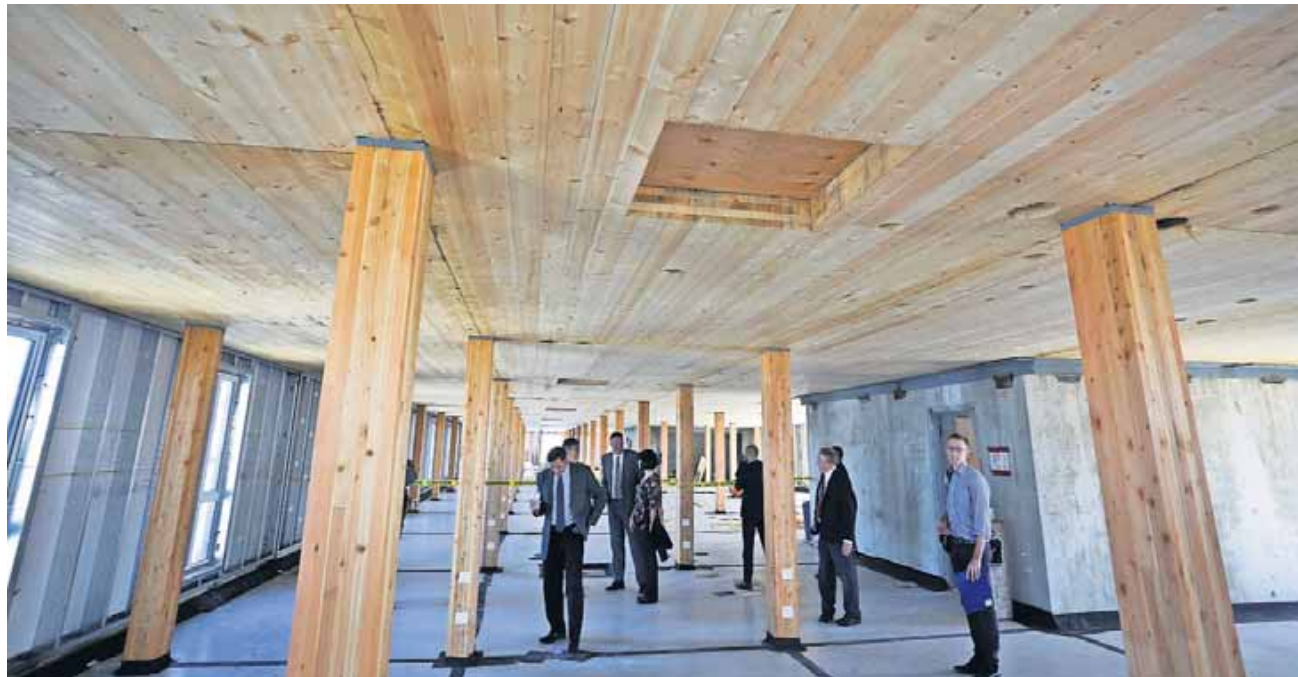
Derzeit der Rekordhalter: das Tall Wood Building in Vancouver. Das Studentenwohnheim der University of British Columbia ist 53 Meter hoch und umfasst 18 Etagen. Seit vergangener Herbst ist es bewohnt. FOTO: IMAGO
