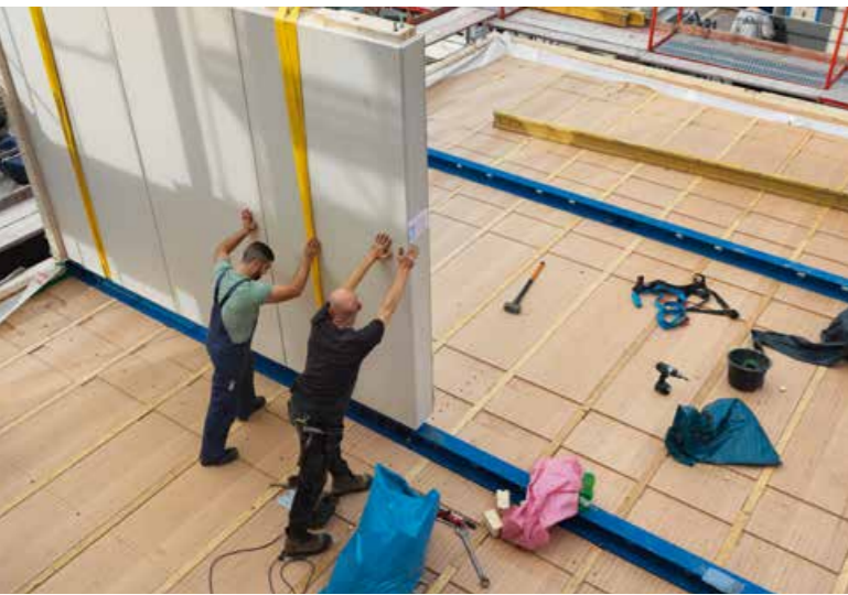
▲ Das fertig vorproduzierte Holztafelbau-Wandelement wird auf die HBV-Decke platziert
